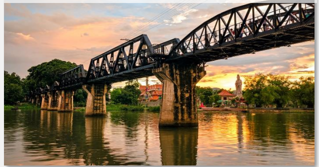
Γέφυρα Ποταμού Κβάι
