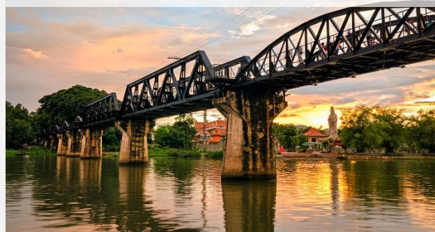
Γέφυρα Ποταμού Κβάι
