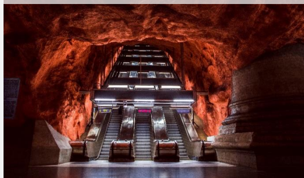
σταθμός μετρό, Στοκχόλμη
