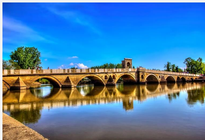
Γέφυρα στην Αδριανούπολη πάνω από τον ποταμό Έβρο
