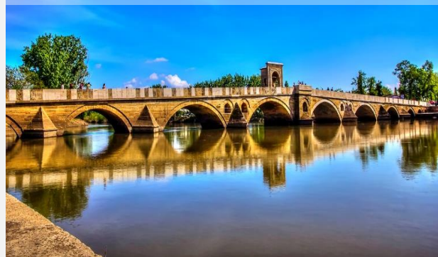
Γέφυρα στην Αδριανούπολη πάνω από τον ποταμό Έβρο
