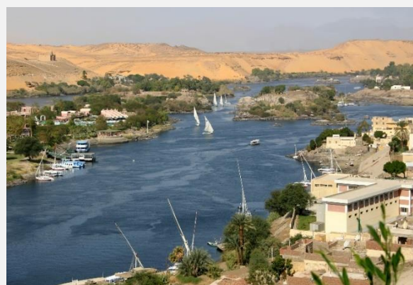
Θέα στον Νείλο από το φράγμα του Ασσουάν
